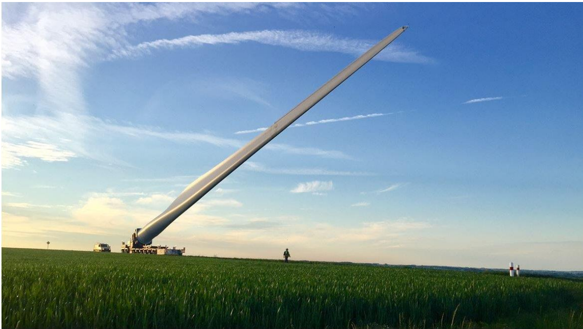
Figure 5 : Photographies d'utilisation du blade lifter, EDF Renouvelables, 2017
