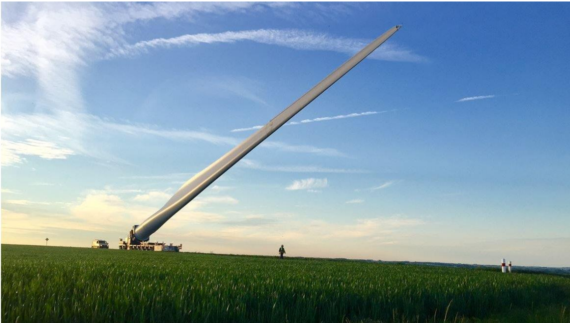
Figure 20 : Photographies d'utilisation du blade lifter, EDF Renewables, 2017
